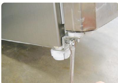
27. Перенесите на другую сторону КОЛПАЧОК ОТВЕРСТИЯ ДЛЯ НИЖНЕЙ ПЕТЛИ и установите обратно ПЕРЕДНЮЮ КРЫШКУ НОЖЕК при открытой дверце.
