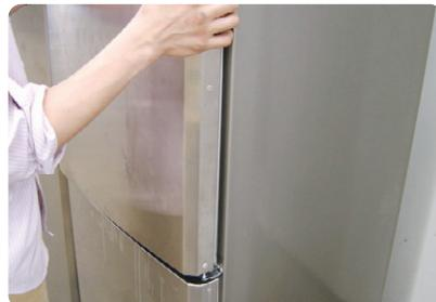
5. Демонтируйте КРЫШКУ ПРОВОДОВ ДВЕРЦЫ в верхней части дверцы холодильной камеры при помощи отвертки с плоским лезвием, вставив лезвие в указанное место.
