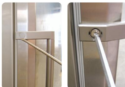
30. Переставьте КОЛПАЧОК ОТВЕРСТИЯ ДВЕРЦЫ с помощью отвертки Phillips.
